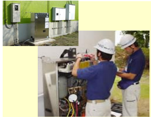
■給水ポンプ点検
