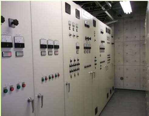
■給水施設点検
