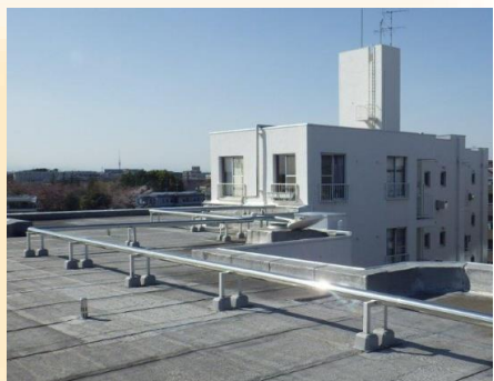
■屋外給水管改修工事
