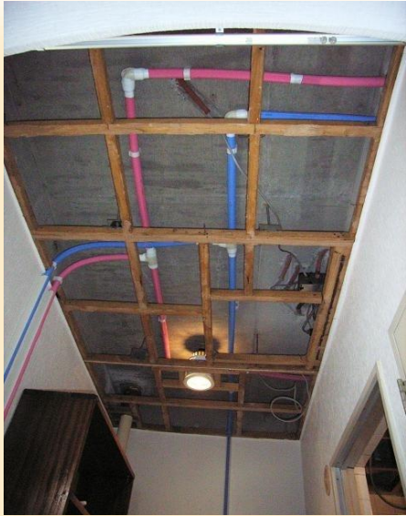
■室内給水・給湯管更新工事（天井配管）
