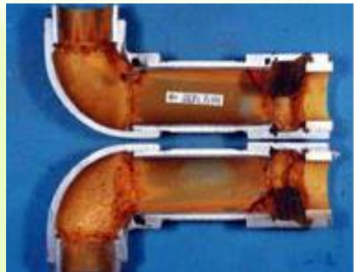
■給水管の抜管調査
