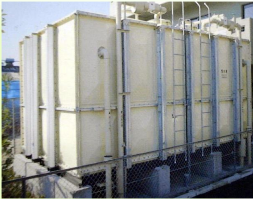
■貯水槽清掃は年に1回義務づけられています
