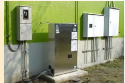
■給水直結増圧化工事
