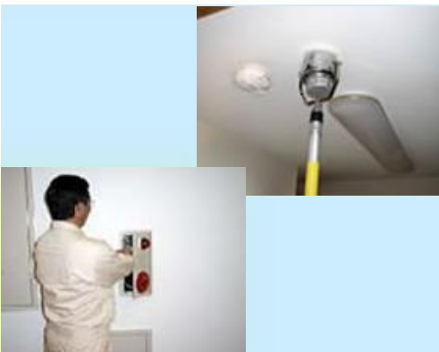
■消防設備点検
