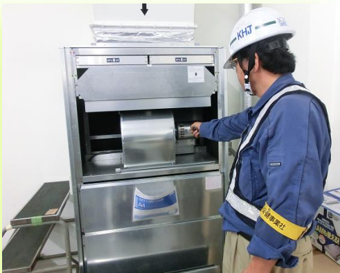
■空調設備点検
