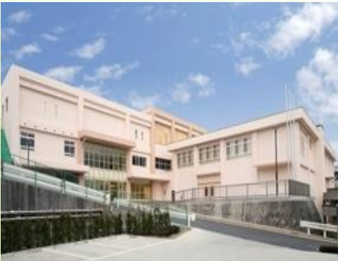
■ 川崎北部養護学校新築工事（空調）
