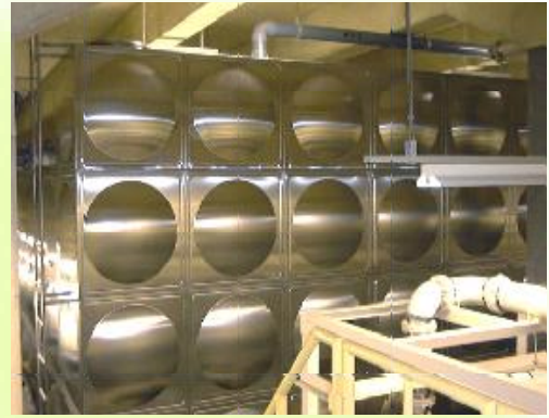
■ 受水槽設置工事
